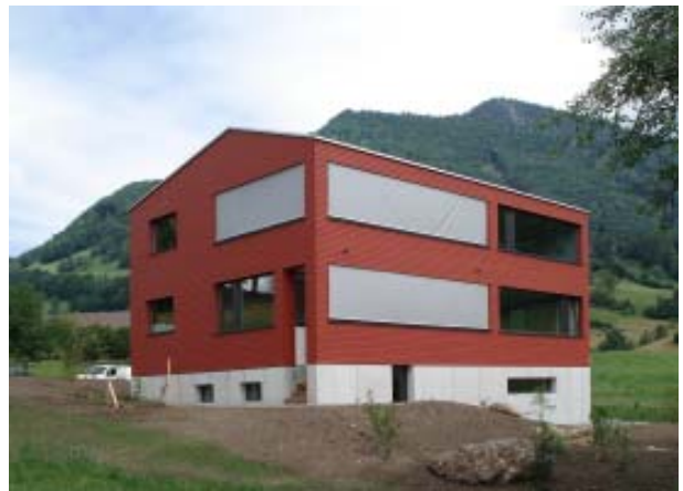
Neubau EFH Grob - Schlatter, Weggis realisiert 2008 - 2009
